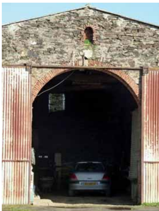
Figure 48 : Grange à nef à Tillières
