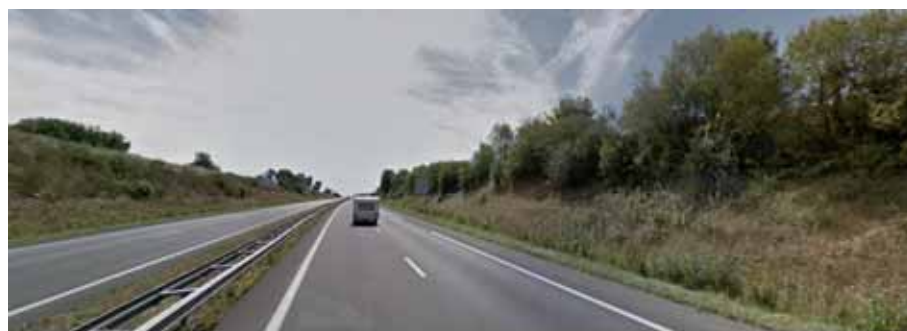
Vue 1, Présence d'un talus planté masquant les co-visibilités sur le paysage
