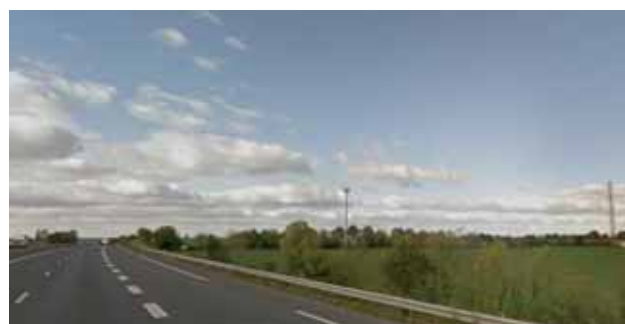
Vue 6, co-visibilité importante avec la zone commerciale
