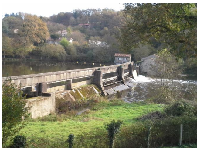
Barrage Le Longeron - Novembre 2015
