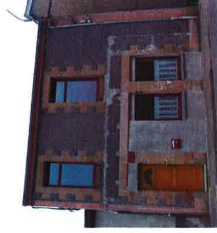
Immeuble de qualité à réhabiliter
