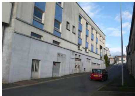
En remontant la rue d'Aiguefou
