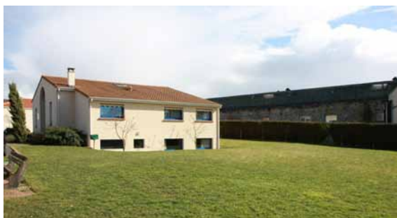
Confrontation entre deux types de construction qui cohabitent très mal, le cabinet médical assimilable à du pavillonnaire construit sur un grand espace vert de pelouse ; derrière les vestiges de l'usine.
