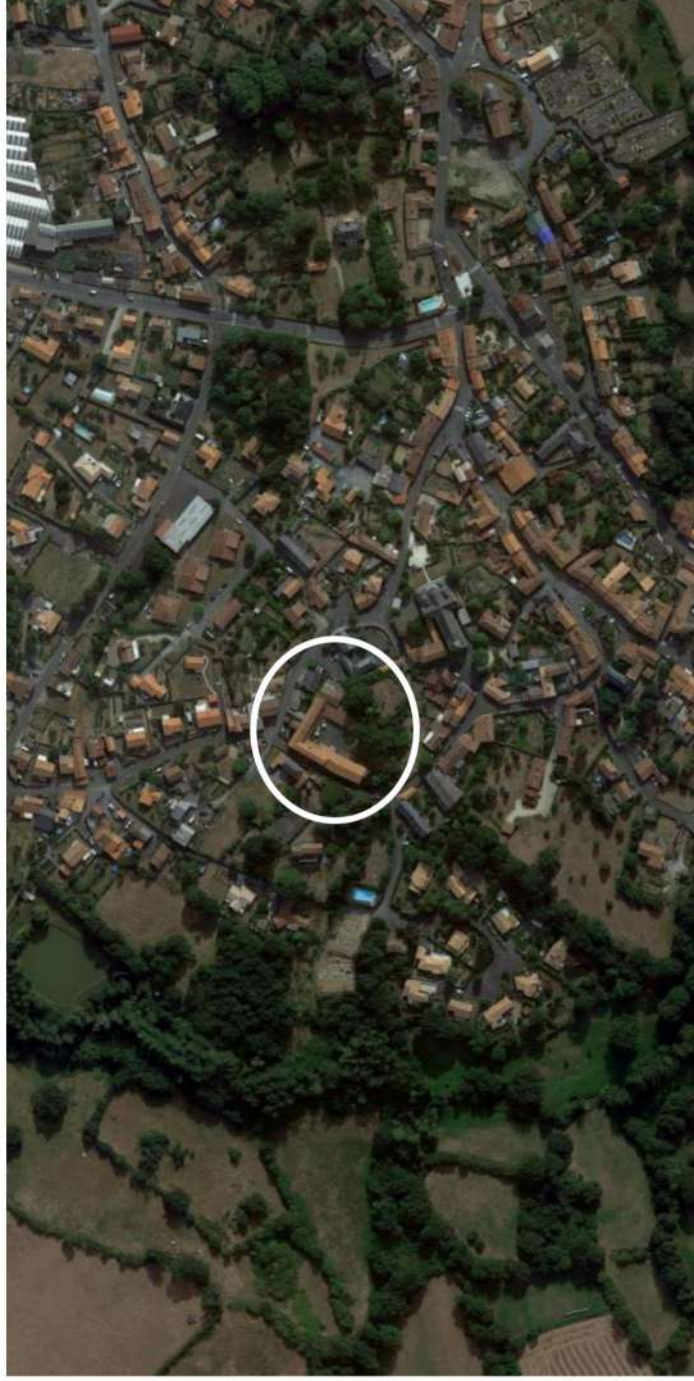
Localisation du site dans le centre bourg de Montfaucon-Montigné – Rue Guillaume René Macé
