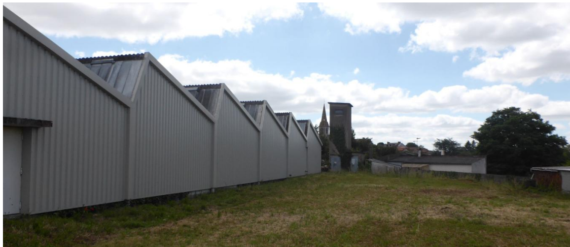
Photo 6. Toiture shed visible depuis l'arrière du site
