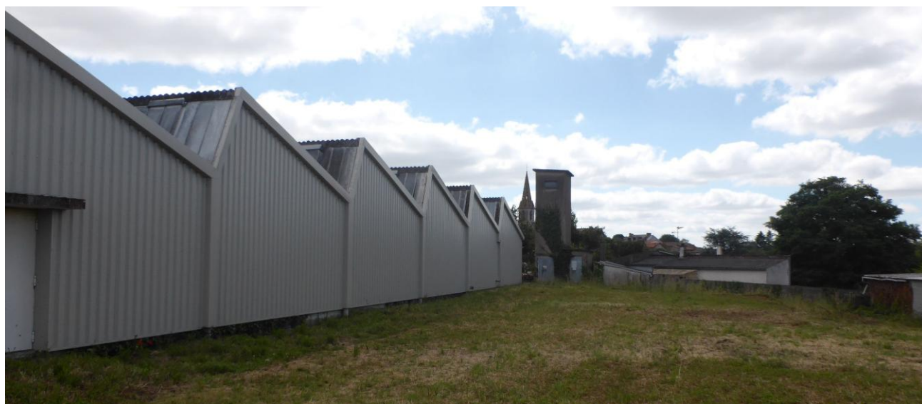
Figure 21. Vue sur l'arrière du bâtiment principal de l'entreprise Audouin
